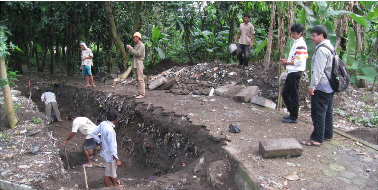
Abb. 8: Aushubarbeiten am Unterbecken
