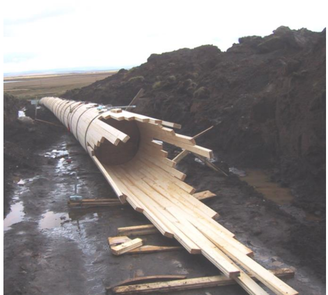
Abb. 1: Erdverlegtes Holzdruckrohr im Bau
