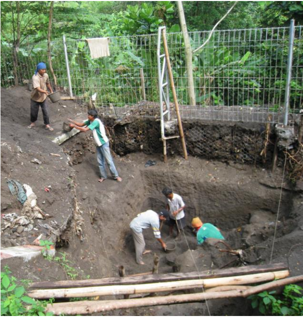
Abb. 6: Anfängliche Erdarbeiten am Oberbecken
