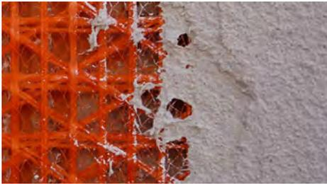
Detailaufnahme von EQ-Grid: Das technische Textil eine ausgeklügelte Textilstruktur aus Glas- und Kunststofffasern wird mit einem speziellen Mörtel befestigt. (Quelle: Dr. Günther Kast GmbH & Co. KG)
