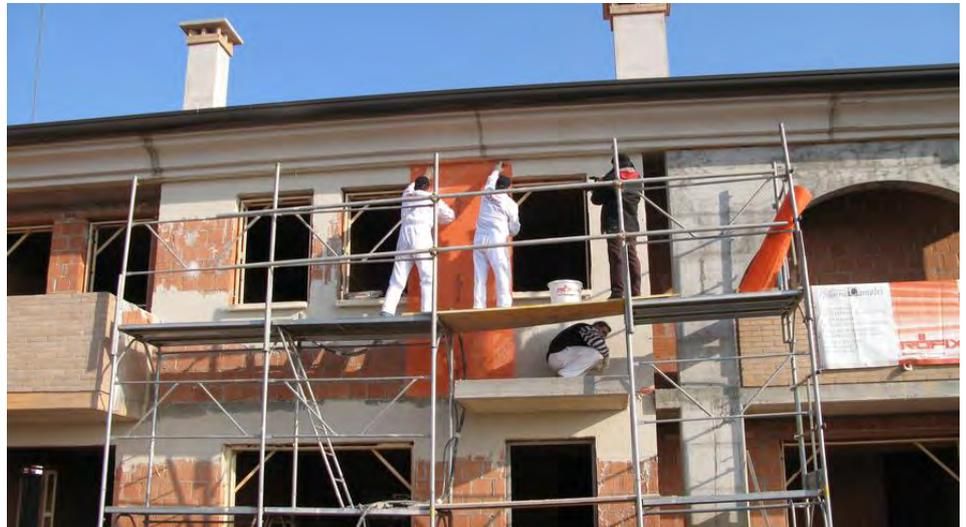
In langen Bahnen wird das Erdbebenschutzgewebe EQ-Grid auf das gesamte Mauerwerk aufgebracht und mit einem speziellen Mörtel verputzt. Im Ernstfall hält es die bröckelnde Gebäudestruktur zusammen und Rettungswege frei. (Quelle: M. Urban/KIT)
